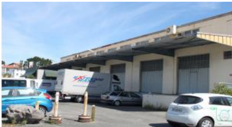
Côté rue: un parking clients de bonne capacité (28 places environ)
